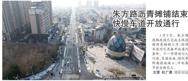
1月5日,朱方路 道路改造已完成主线道 路沥青摊铺工序,快慢 车道均已具备开放通行 条件。下一步将进行人 行道、交通设施、绿化等 附属设施施工,计划春 节前全面完工。
