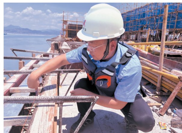
为确保浇筑完成后外观尺寸符合设计规范要求，润华公司项目总监周永现场测量护轮坎高度和宽度。 润华公司 殷勤 摄
