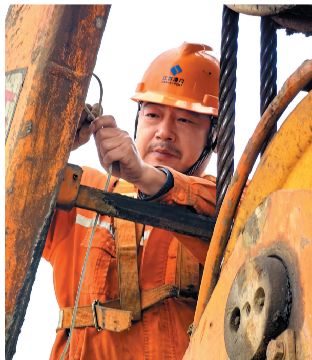
为确保高空作业时员工的安全与设备的可靠性兼顾，操作事业部电工孙松正专心修复抓斗爬梯的防坠落装置。 资产分公司(高新公司) 韦紫昇 摄
