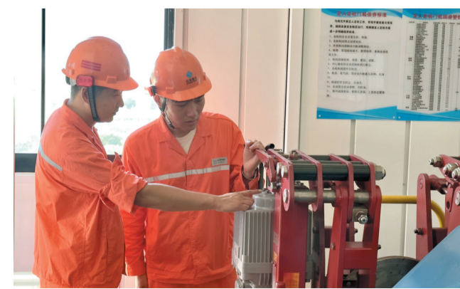
溧阳港一线员工用双肩扛起责任，用汗水致敬敬业，用初心坚守岗位。 溧阳港 黄胜 摄
