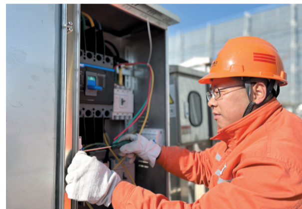
为确保大港分公司1、2号污水站防洪水泵稳定、高效运行，兴港分公司养护中心修理班成员正在进行防洪水泵专用配电箱安装和电缆铺设工作。 兴港分公司 董倩 摄
