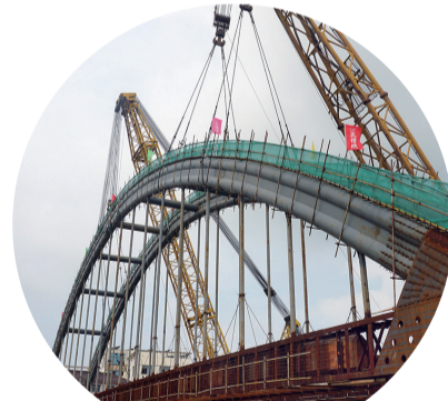
辛丰镇人行桥顺利 完成主跨钢构整体吊装
