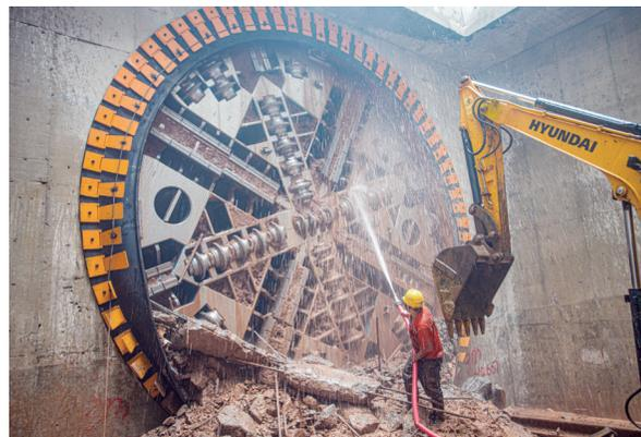
宁句城际轨道向容境内第一条隧道盾构机出洞
