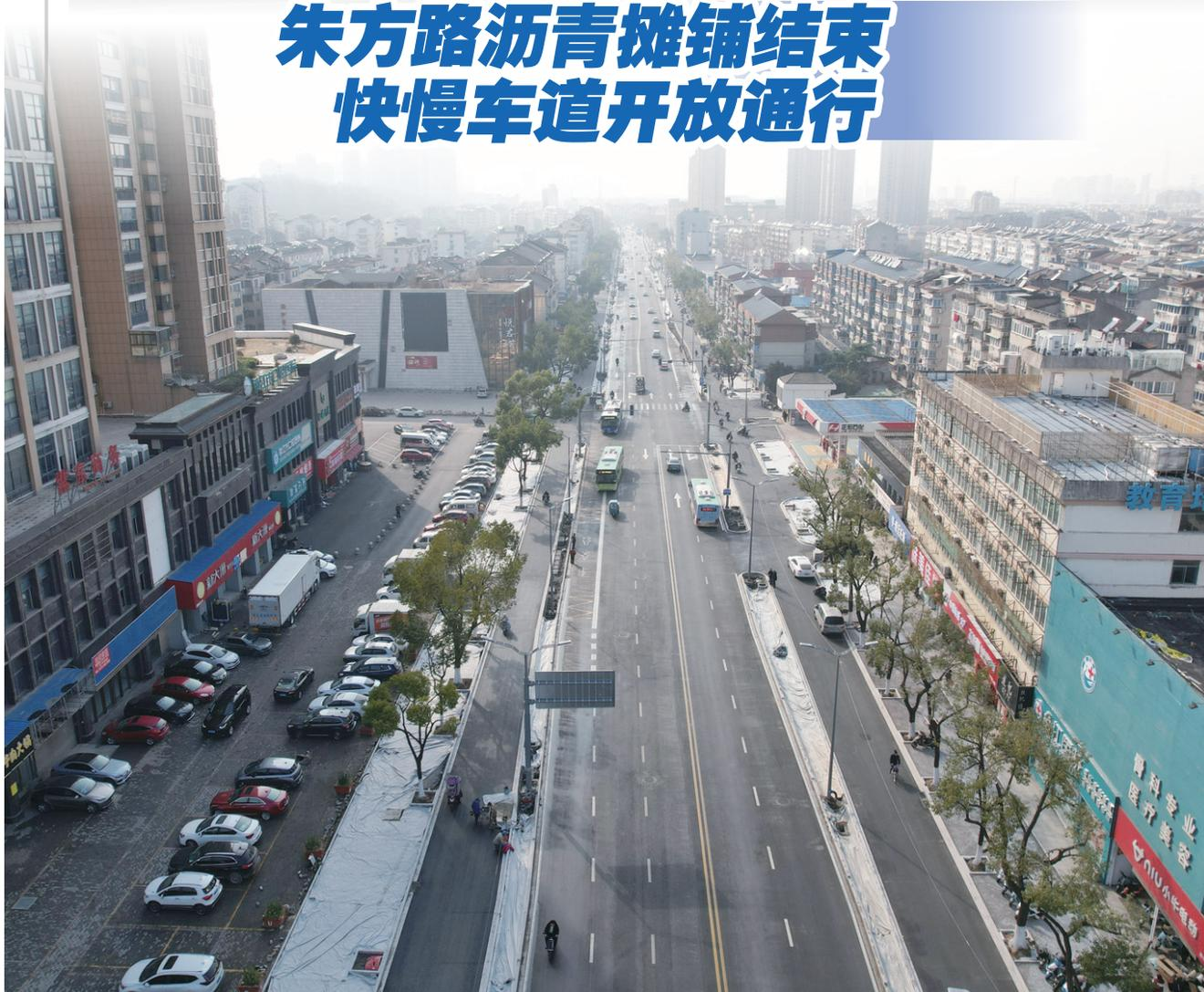
1月5日,朱方路道路改造已完成主线道路沥青摊铺工序,快慢车道均已具备开放通行条件。下一步将进行人行道、交通设施、绿化等附属设施施工,计划春节前全面完工。
