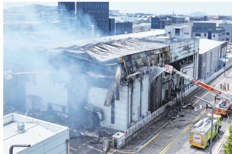
消防员在韩国京畿道华城市的电池工厂火灾现场灭火。 新华社/美联
