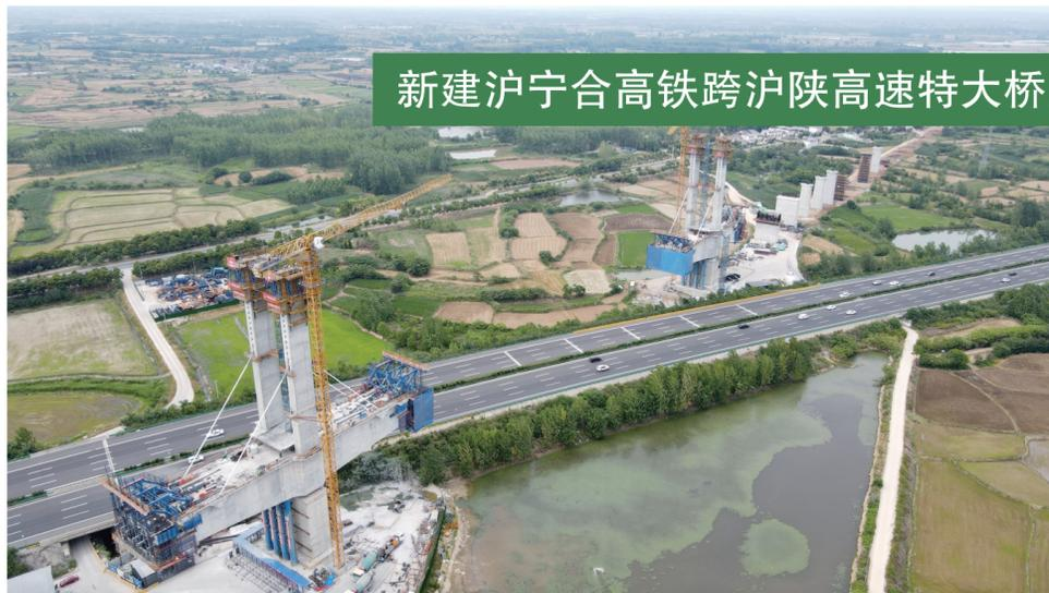
这是新建沪宁合高铁跨沪陕高速公路特大桥主桥塔柱封顶施工现场(6月18日摄,无人机照片)。
