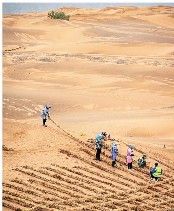
治沙工人在宁夏中卫市境内的腾格里沙漠铺设刷状网绳式方格沙障(5月29日摄)。
