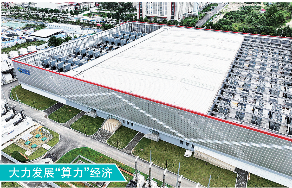
这是位于贵安新区的一处大数据处理中心(无人机照片,6月14日摄)。近年来,贵州省贵安新区把综合试验区建设与大数据战略行动统筹推进,积极履行国家大数据(贵州)综合试验区试验任务,打造算力保障基地和智算基地,聚焦“智算、行业大模型培育、数据训练”,数字经济得到大力发展。
