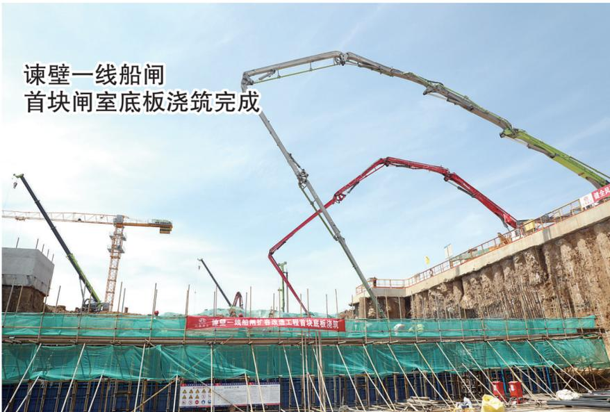
6月10日,省重点水运工程——谏壁一线船闸扩容改造工程迎来了关键节点。从当天6时至18时,经过12个小时的连续奋战,首块18#闸室底板浇筑完成。谏壁一线船闸主体第一块实体结构施工完成。 王晔晨 黄帅 摄影报道
