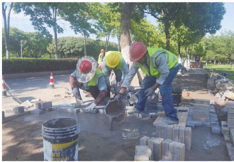
金港大道人行道路面修复。潘宇琴摄
