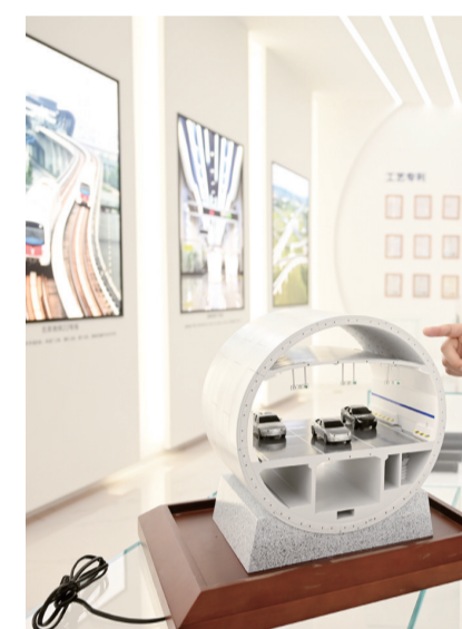
图为刘安在介绍盾构隧道内部结构预制构件。 程莹 摄
