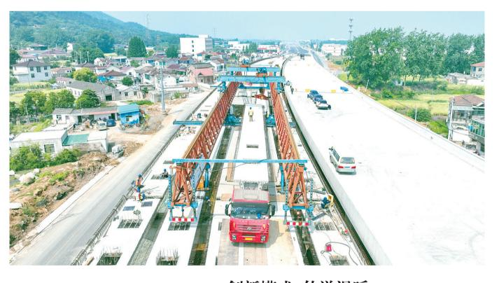
5月7日,随着312 国道346国道镇江戴家 门至高资段改扩建工程 G346-CQ1标最后一 片预制梁稳稳落在墩台 上,工程全线预制梁全 部架设完成。为保证架 梁顺利进行,项目部提 前研究部署、加强施工 现场过程控制,确保任 务顺利完成。
