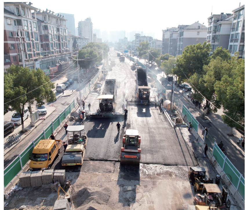
11月7日,朱方路道路改造工程光华雅居至北府路段开始快车道沥青摊铺。 文雯 杜广晨 摄
