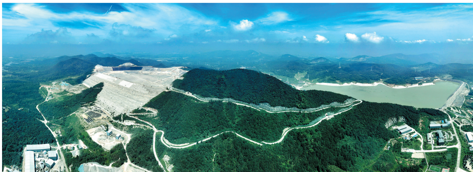
句容仑山湖抽水蓄能电站 石小刚 摄
