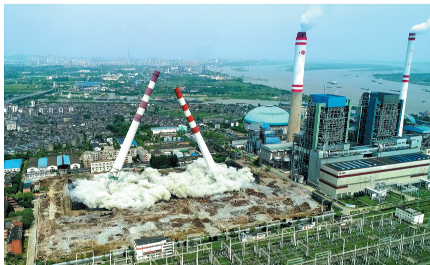
谏壁电厂服役40余年的4×330MW机组锅炉烟囱成功爆破拆除 卞恒庆 摄
