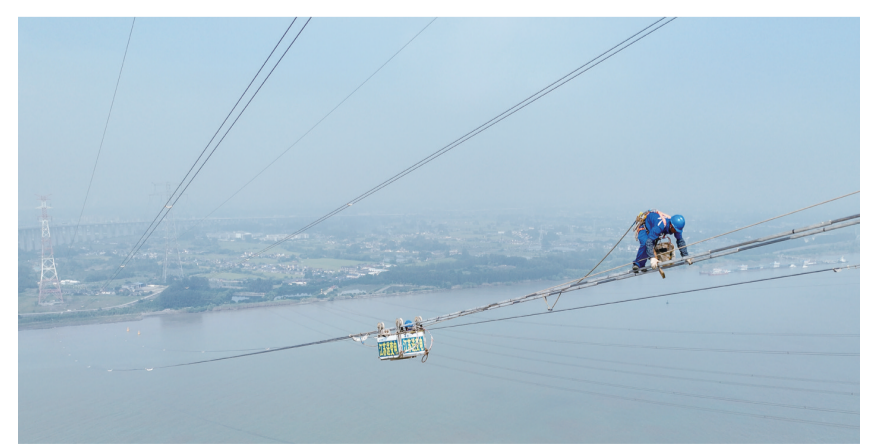
9月26日，在江苏镇江，国网江苏电力员工进行导线更换作业(无人机照片)。新华社发
