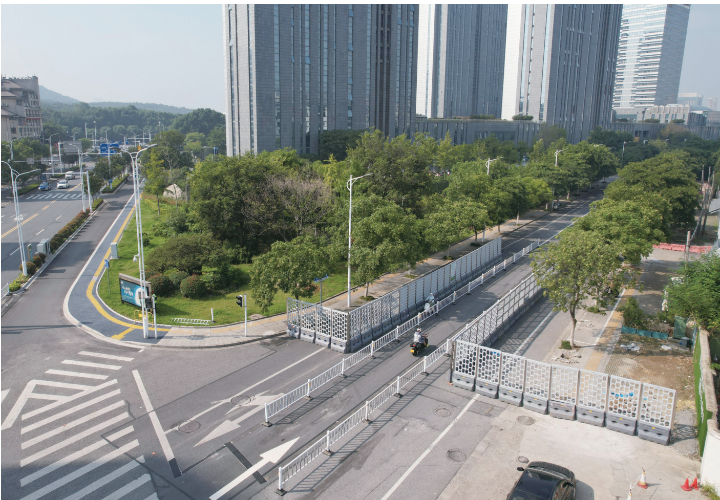
南山路半封闭施工单向通行。
