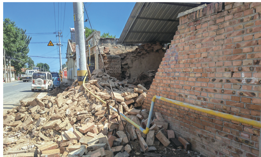
8月6日，在平原县王打卦镇郭家堂村，一处房屋和燃气管道因地震受损。 新华社发
