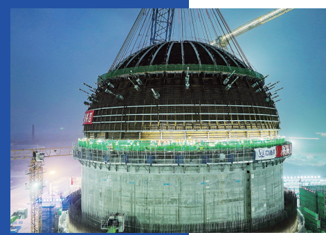
7月25日,徐大堡核电项目3号机组顺利实现穹顶吊装就位。徐大堡核电项目3、4号机组建成后,预计每年可提供160亿千瓦时以上清洁能源,相当于年节约煤炭570万吨,年减少二氧化碳排放量1680万吨,对于保障我国能源安全、优化能源结构具有积极作用。
