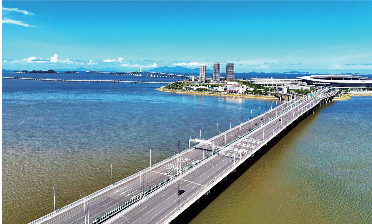
7月11日,车辆在港珠澳大桥上行驶(无人机照片)。
