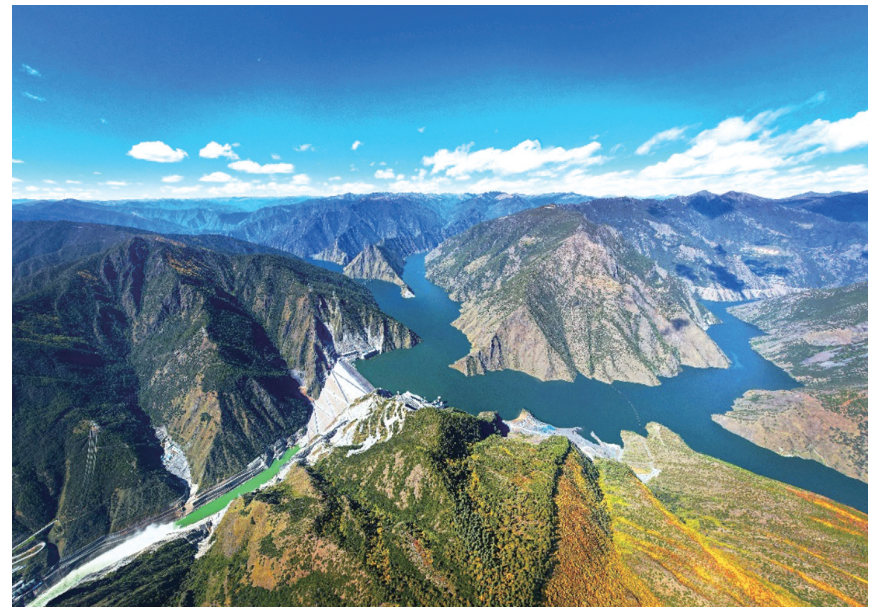
雅砻江两河口水电站水库总库容108亿立方米，是四川省内最大的水库。通过两河口水电站水库的补偿调节，在迎峰度夏期间惠及雅砻江中下游、金沙江下游和长江干流多座水电站。
