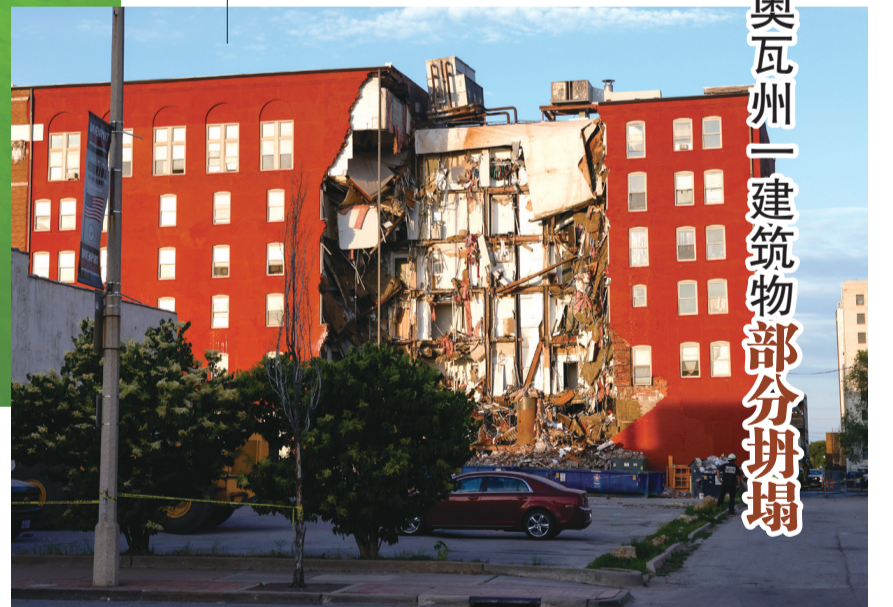
这是5月28日在美国艾奥瓦州达文波特拍摄的建筑坍塌现场。据外媒报道,28日,美国艾奥瓦州达文波特的一栋建筑物部分坍塌,目前伤亡情况不明。新华社/美联
