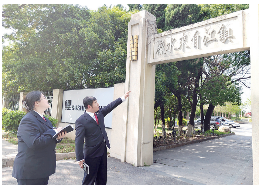
检察官实地查看脱落的牌匾。 焦惟奇 何阳 摄
