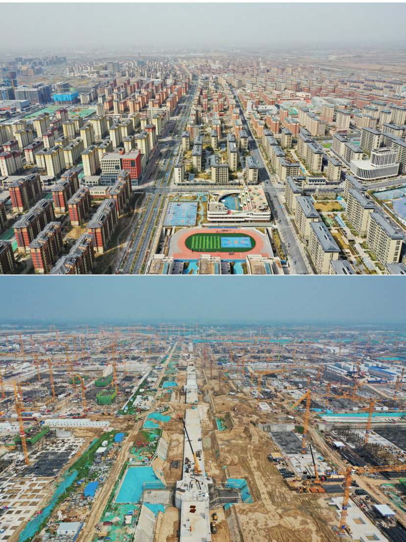
镜头见证雄安“拔节生长” 拼版照片：上图为2023年3月24日拍摄的雄安新区容东片区（无人机照片）；下图为2020年8月11日拍摄的雄安新区容东片区建设现场（无人机照片）。 2017年，设立河北雄安新区的消息如春雷乍响，从白洋淀畔传遍大江南北。雄安新区，从“一张白纸”着墨，每天都在积蓄力量、不断发展。六载光阴，从顶层设计规划到如火如荼大规模建设，一座现代化的城市如今已显现雏形。多年来，记者通过镜头记录下雄安的“拔节生长”。 新华社发
