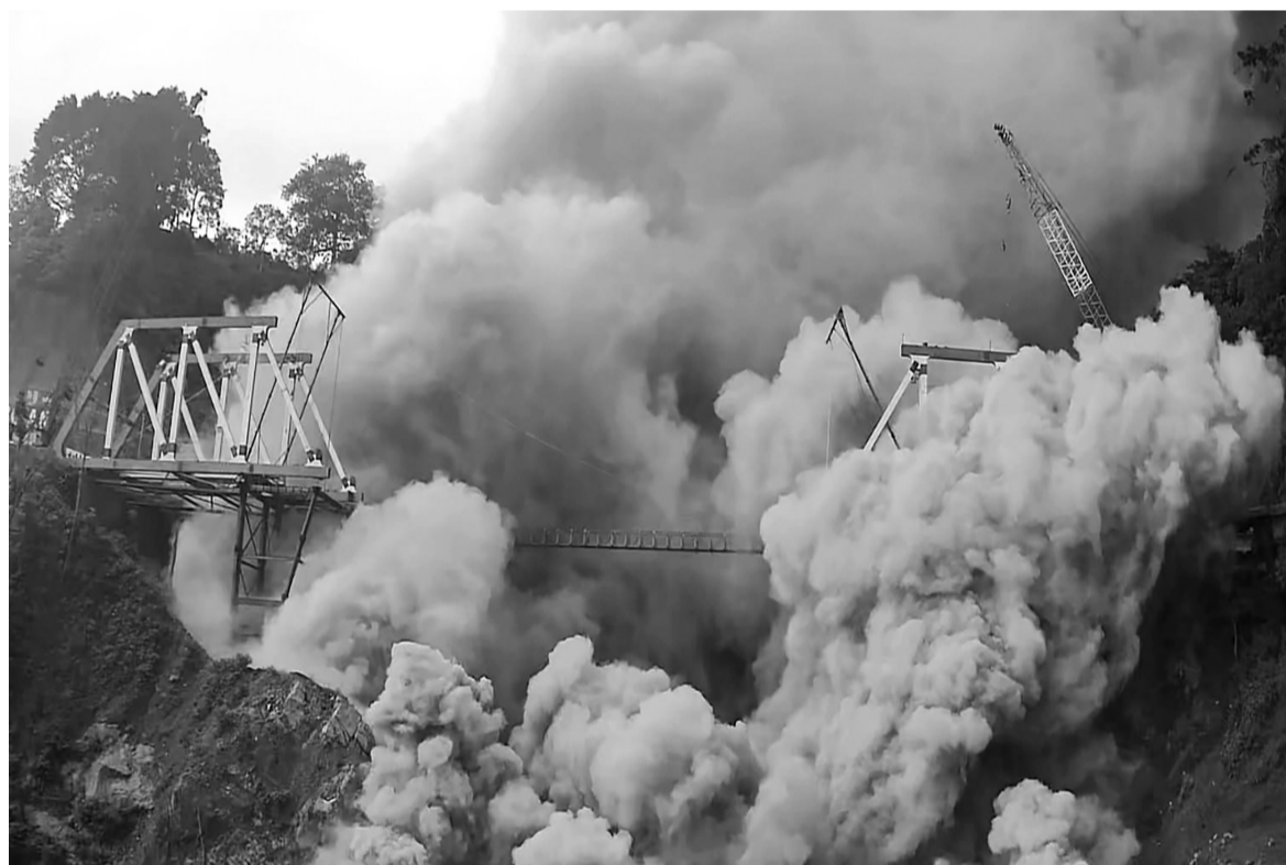
这张由印度尼西亚国家抗灾署提供的照片显示,12月4日,位于印度尼西亚爪哇省卢马姜的一处桥梁被火山灰包围。印度尼西亚爪哇岛东部塞梅鲁火山4日喷发,印尼政府随即将该火山的警戒级别上调至最高级。新华社发
