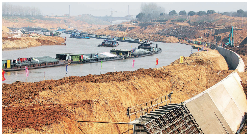
▼2010年,苏南运河四改三工程建设中 石小刚 摄
