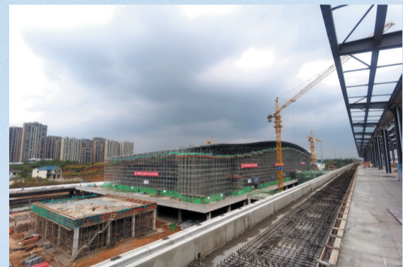
南沿江城际句容段站房
