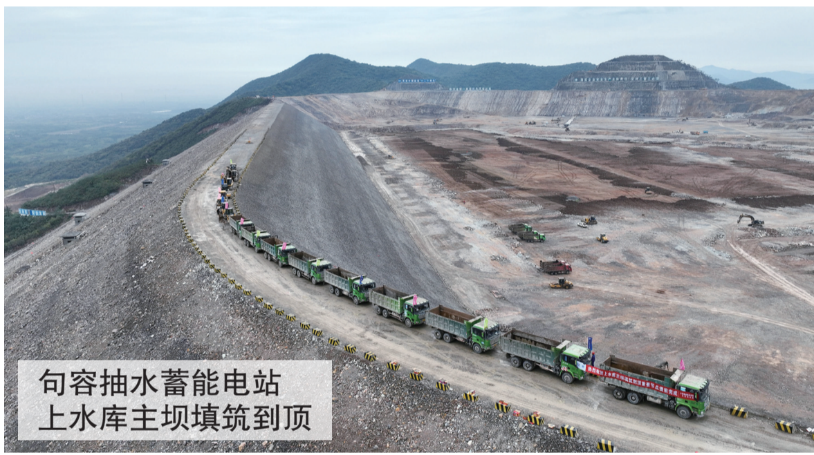
9月28日,位于句容市边城镇境内的江苏句容抽水蓄能电站上水库主坝顺利填筑到顶,标志着该工程进入到新的建设阶段。据了解,上水库主坝坝顶高程272.4米,最大坝高182.3米,坝顶长度810米。上水库采用库岸沥青混凝土面板堆石土工坝的防渗方式。江苏句容抽水蓄能电站是国家电网公司抽水蓄能“十三五”发展规划重点工程之一,于2017年3月正式开工建设,首台机组计划于2024年底投产发电,2025年全部投产发电。辛一 王威康 步婷 摄影报道
