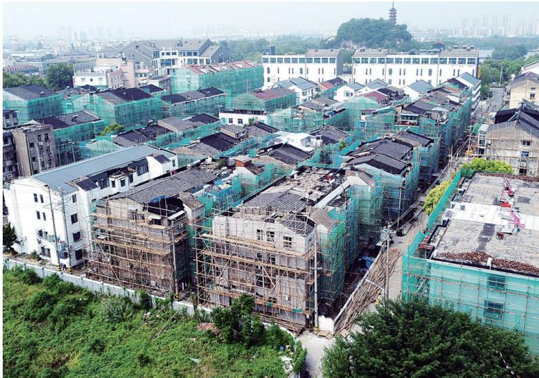
9月1日,润州区江南新村老旧小区改造现场正在进行屋面圈梁钢筋模板施工。
