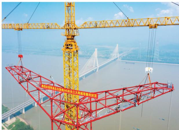
8月1日，安徽送变电工程有限公司施工人员在池州长江大跨越南岸跨越塔封顶施工现场作业(无人机照片)。当日，经过建设者150余天的奋战，白鹤滩至浙江±800千伏特高压直流输电工程安徽池州长江大跨越高345米的南岸跨越塔成功封顶。白鹤滩是我国实施“西电东送”战略的重点工程，送端连接目前世界在建最大水电站白鹤滩水电站，受端位于杭州临平区浙江换流站，线路全长2140.2公里。新华社发
