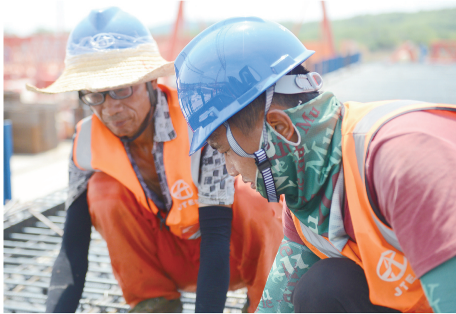
G312G346-CQ3标预制梁场建设现场。工人们奋战在312国道宁镇段快速化改造工程。黄帅 陆晓霖 摄
