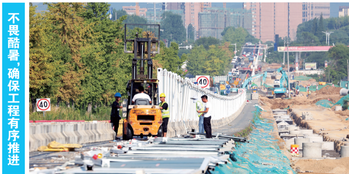
7月13日，346国道镇江城区段城市化改造工程的施工人员不畏酷暑，坚守建设一线，为加快工程建设和打造良好的路域环境挥洒汗水，接受“烤”验。据了解，项目部采取了一早一晚的工作方式，确保工程有序推进。 文雯 摄影报道
