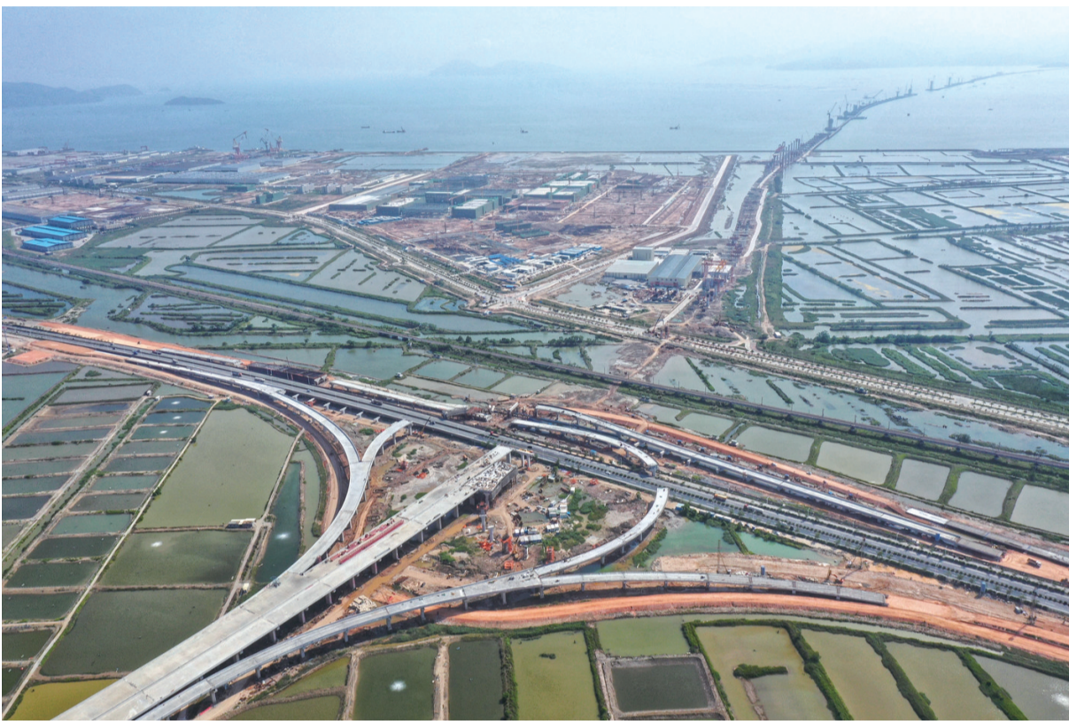
5月5日拍摄的珠海鹤港高速公路二期工程高栏港枢纽立交桥建设现场(无人机照片)。
