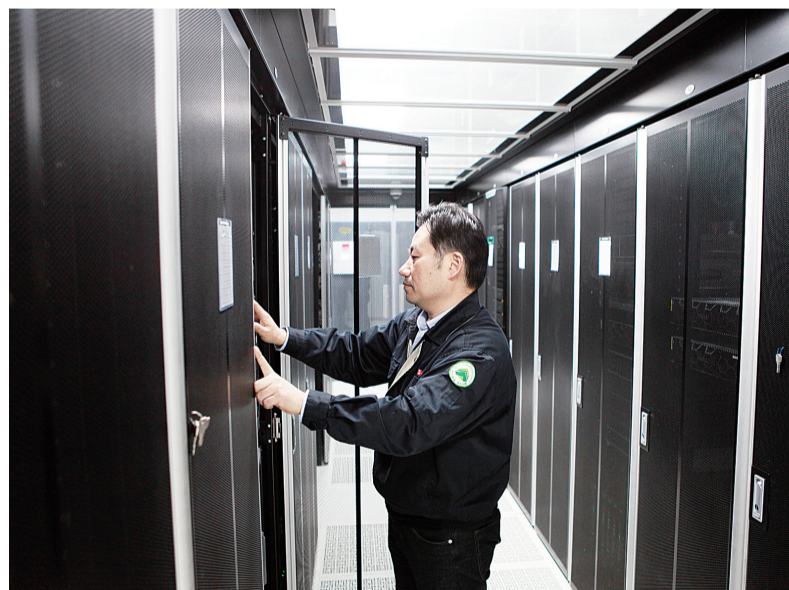
路安炎正在调试数据机房设备。
