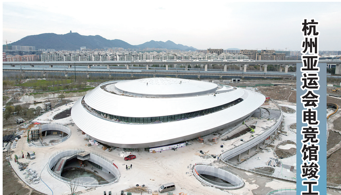
从空中俯瞰即将竣工的杭州亚运会电竞馆(无人机照片，2月23日摄)。
