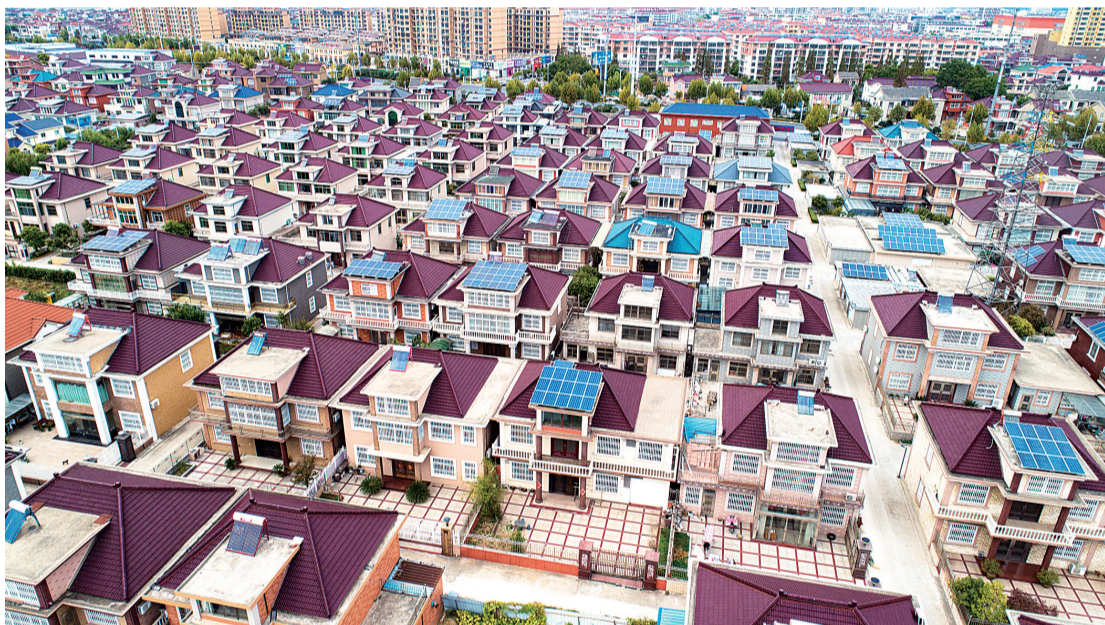
近年来，扬中涌现了一批光伏村、光伏小区，安装家庭屋顶光伏与配套微电网设备，为绿色能源岛建设注入了新动能。 摄影：杨新
