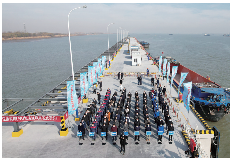
润祥LNG加注站码头正式运行。 崔宁华 摄
