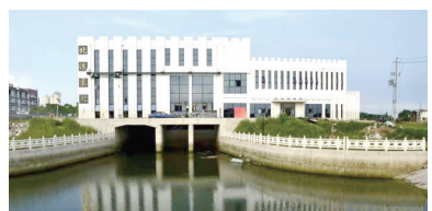
北港泵站。鲍鑫 摄
