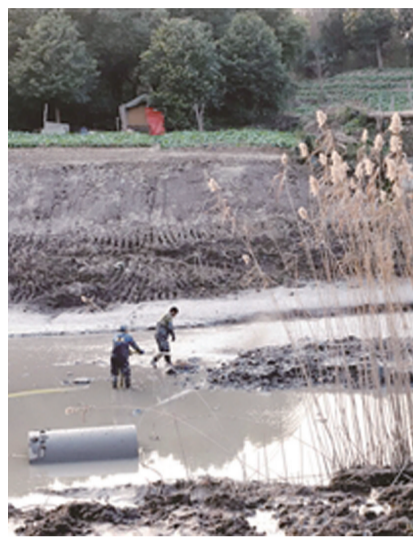
粮山河整治工程现场清淤。王呈 摄
