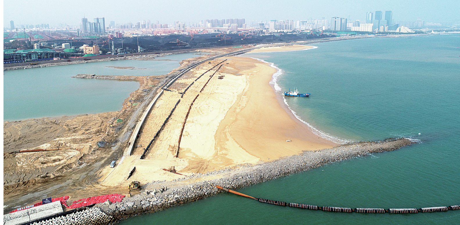
山东省日照市退港还海项目部分区域的施工场面(无人机照片)。山东省日照市日前实施了我国首例港口工业岸线退港还海、修复整治生态岸线项目,实现“港、产、城、海”绿色、协调发展,一片生态“绿丝带”正在城市黄金海岸线上徐徐展开。 新华社发
