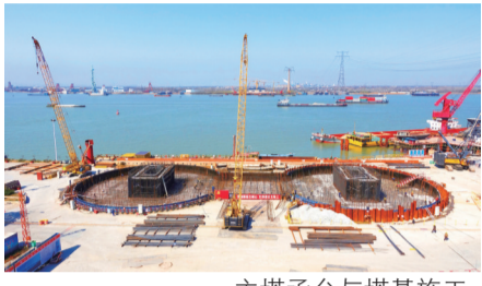
主塔承台与塔基施工。
