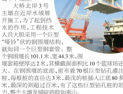
大桥北岸3号主墩在近岸水域展开施工,为了起到挡水的作用,工程技术人员大胆采用一个巨型“哑铃”状的钢围堰结构,就如同一个巨型钢套管。整个钢围堰长101.1米、宽44.3米,围堰箱壁厚达2米,其横截面积比10个篮球场还大。在钢围堰的底部,密布着70根巨型钻孔灌注桩,每根桩的直径达3米,最浅的桩插入江底80多米,最深的则超过百米,有了这些巨型钻孔桩的助力,整个主墩及锚碇将稳如泰山。
