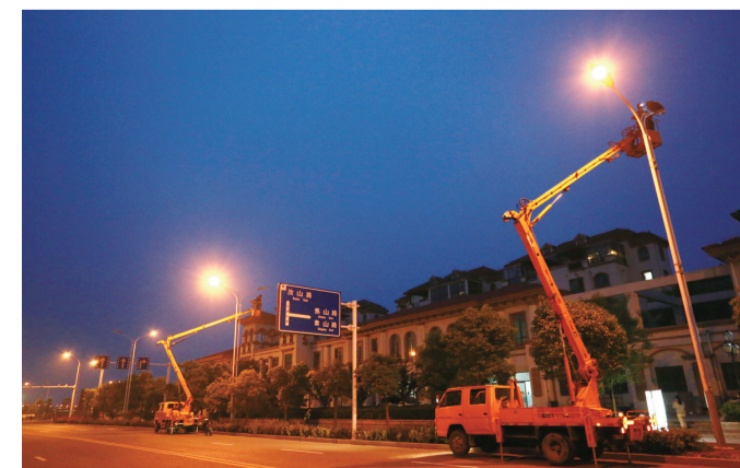
工作人员在维修路灯。文雯 摄
