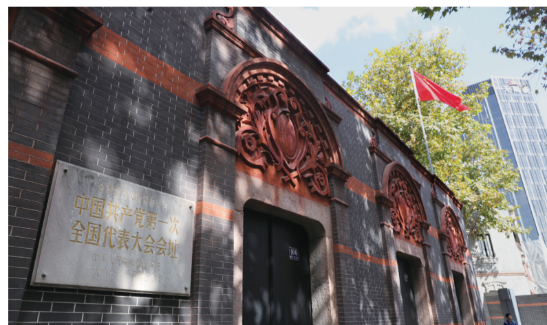
上海中共一大会址纪念馆将进行修缮改造
