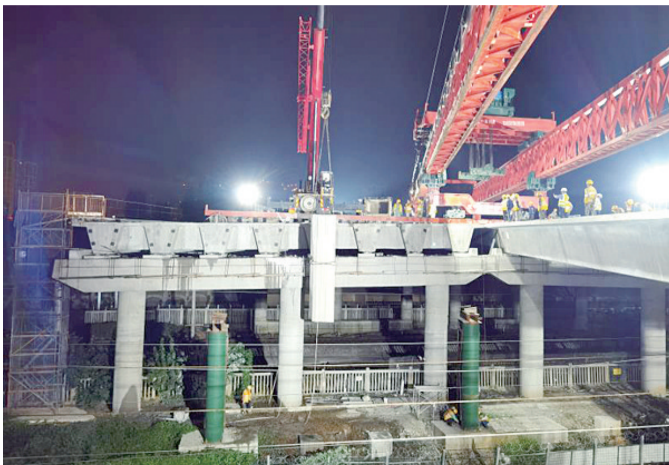
图为施工现场。项目供图
