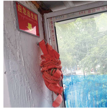
田家门3号群租房整改后二楼窗边的逃生绳
