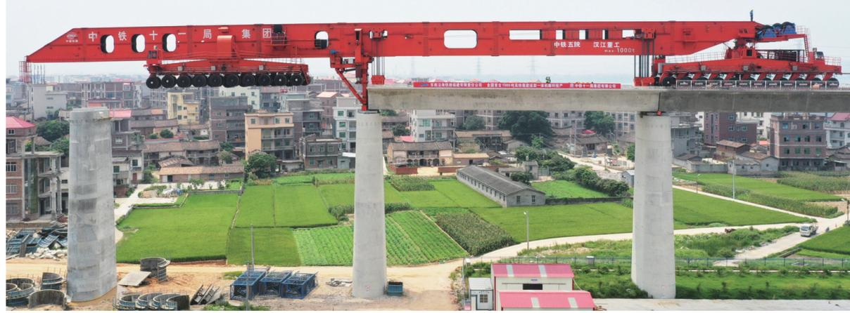
6月22日，中铁十一局集团建设者将一台1000吨箱梁架设在福厦高铁湄洲湾跨海大桥上，标志着我国首台1000吨级高铁箱梁运架一体机成功投入使用，我国高铁装备制造和施工水平获得重大突破。
