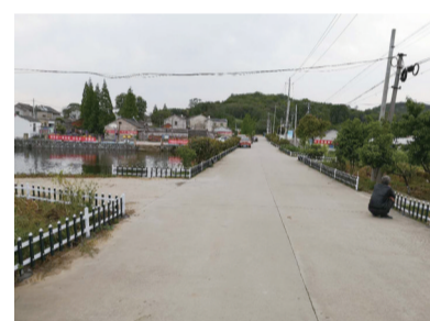
村内道路整治后
