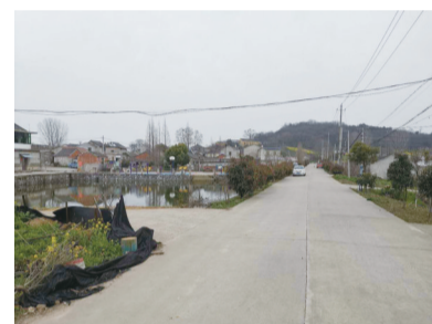
村内道路整治前
