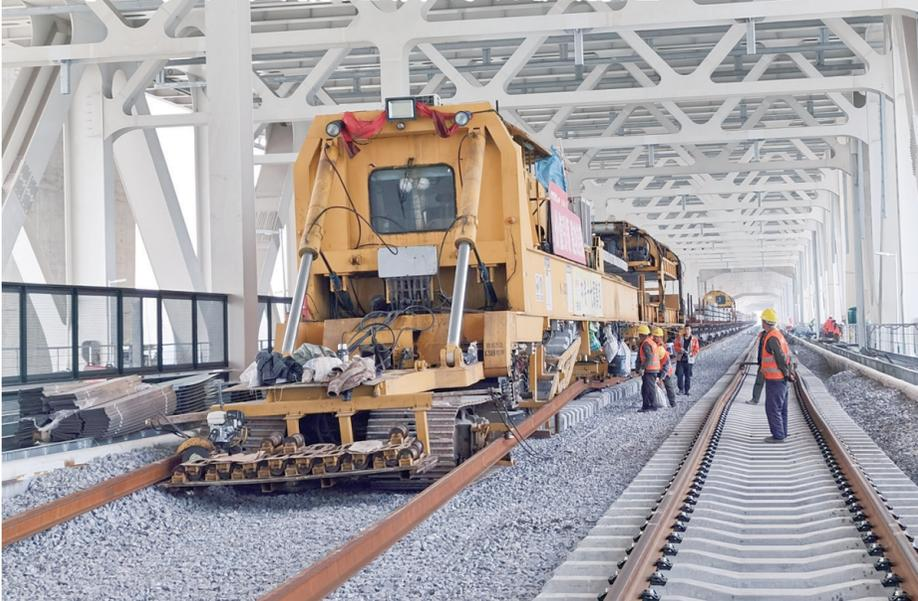
随着CPG500铺轨机“吐出”最后一组轨枕,并完成钢轨牵引,4月22日,五峰山长江大桥连镇线双轨轨道正式贯通。据介绍,4月16日开始铺轨,负责主桥施工的中铁大桥局连镇铁路项目部在3月9日已把20000吨道砟铺设完成,为按时铺轨奠定了坚实基础。
