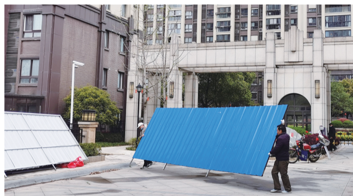
拆除小区临时围挡
